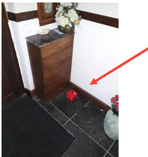
Figuur 3 – meetopstelling schade entree
