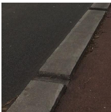
Figuur 2 - verhoogde wegmarkering van beton
